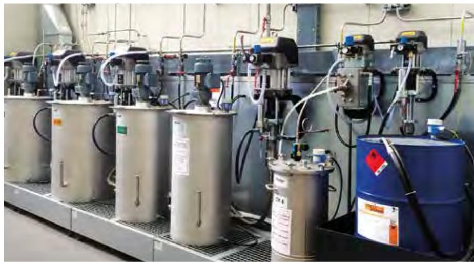
Zentrale Lackversorgung mit WALTER Farbmischbehältern Typ FMB:
