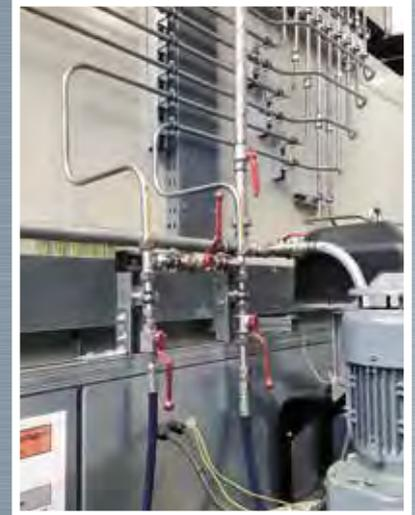
Um bei Zirkulationssystemen den Materialdruck auch für weiter entfernte Abnahmestationen zu garantieren, wurden Umschaltthähne vorgesehen. Die Ausführung der Rohrleitungen ist vorbildlich.
